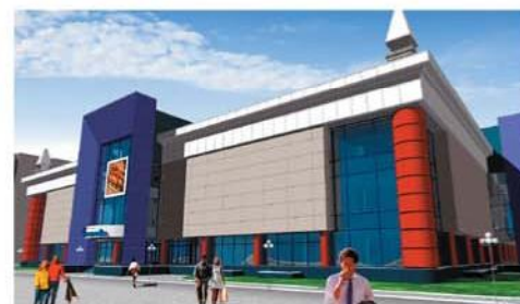
Торговый комплекс на ул. Взлетная
